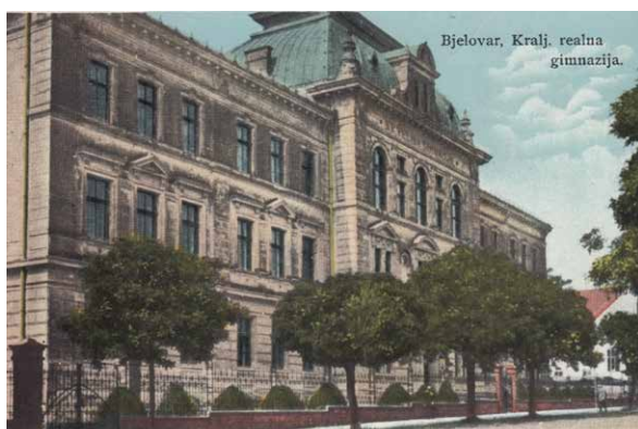
Bjelovar, Kraljevska realna gimnazija, 1935.
