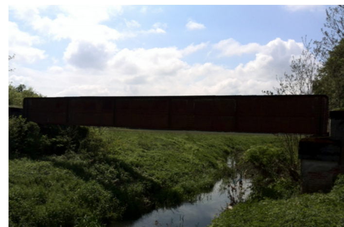
S izviđanja trase – stari željeznički most u Pavlovcu (H. Supančić)
